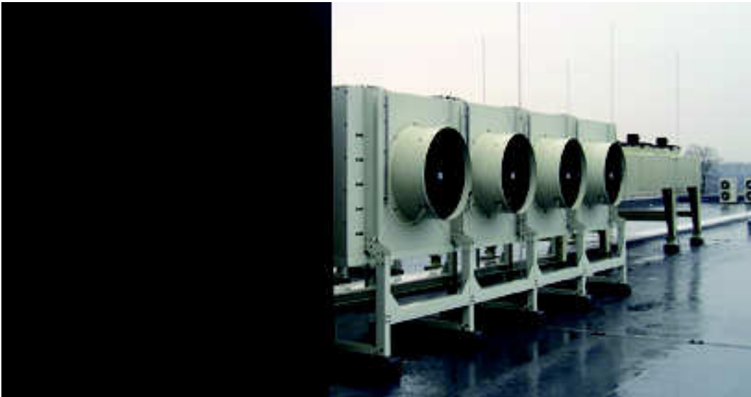
Buitenverdamper(s) met links de donkergekleurde machinekamer
